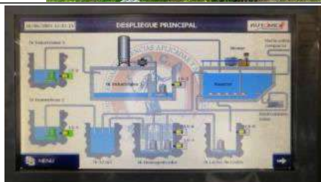
Figura 1. Vista panorámica de la PTAR principal de la Universidad, la cual desarrolla un tratamiento de tipo terciario con lecho de lodos activados y detalle del sistema LCD del tablero de control de bombas. Desde su entrada en operación en el año 2012 la PTAR ha sido constantemente actualizada para poder ofrecer un mejor servicio en el tratamiento del agua residual producida.
