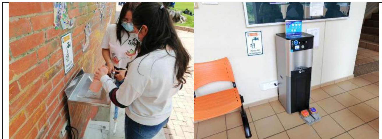
Figura 3. Dispensadores de agua potable fría y/o caliente de libre utilización que se encuentran en diferentes puntos del campus y que forman parte del bienestar institucional que ofrece la Universidad a cada uno de sus miembros (incluidos visitantes).
