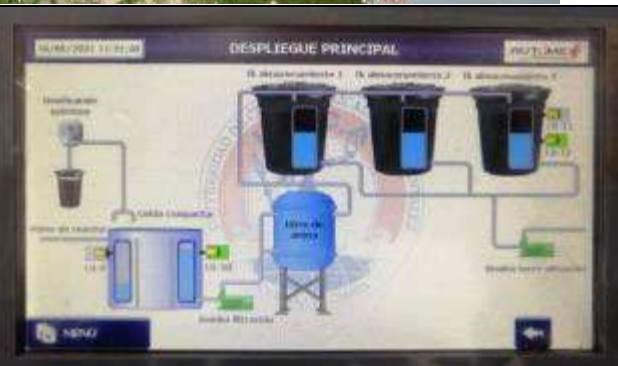
Figura 1. Vista panorámica de la PTAR principal de la Universidad, la cual desarrolla un tratamiento de tipo terciario con lecho de lodos activados y detalle del sistema LCD del tablero de control de bombas. Desde su entrada en operación en el año 2012 la PTAR ha sido constantemente actualizada para poder ofrecer un mejor servicio en el tratamiento del agua residual producida.
